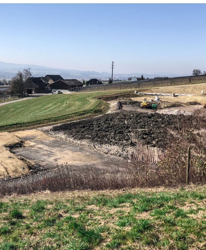
Einbauarbeiten auf der Deponie Kehlhof
