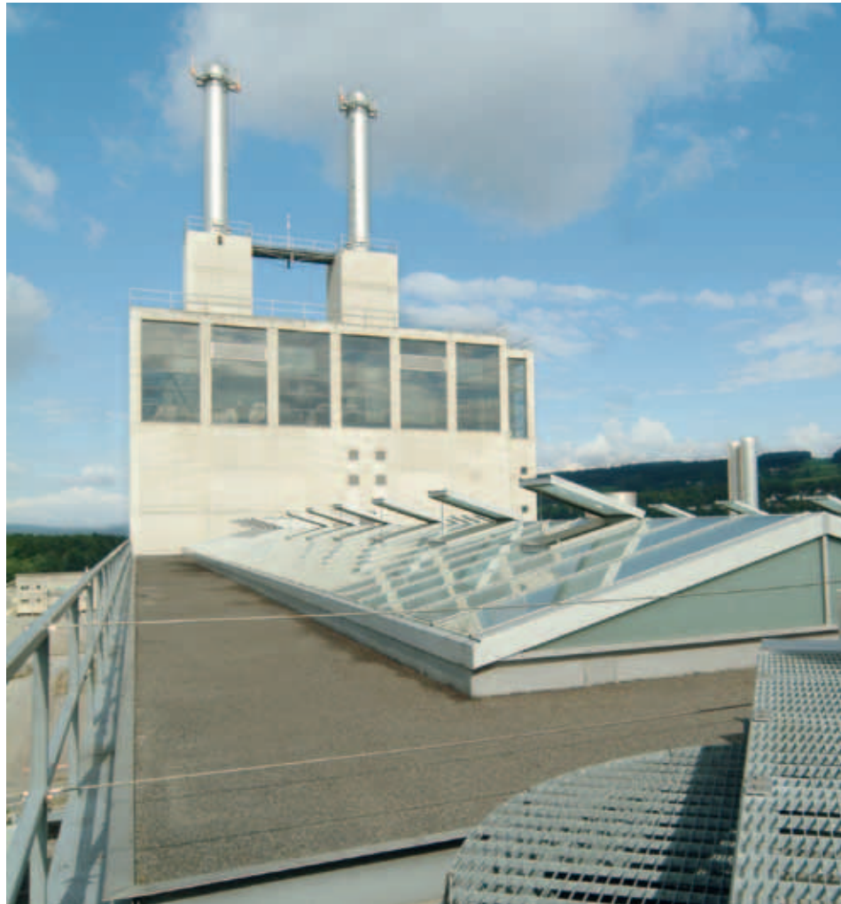
Saubere Energie aus thermisch verwerteten Abfällen: Die Kehrichtverbrennungsanlage des Verbands KVA Thurgau produziert als grösstes Kraftwerk im Kanton Thurgau wertvolle, einheimische Energie in Form von Dampf und Strom.
