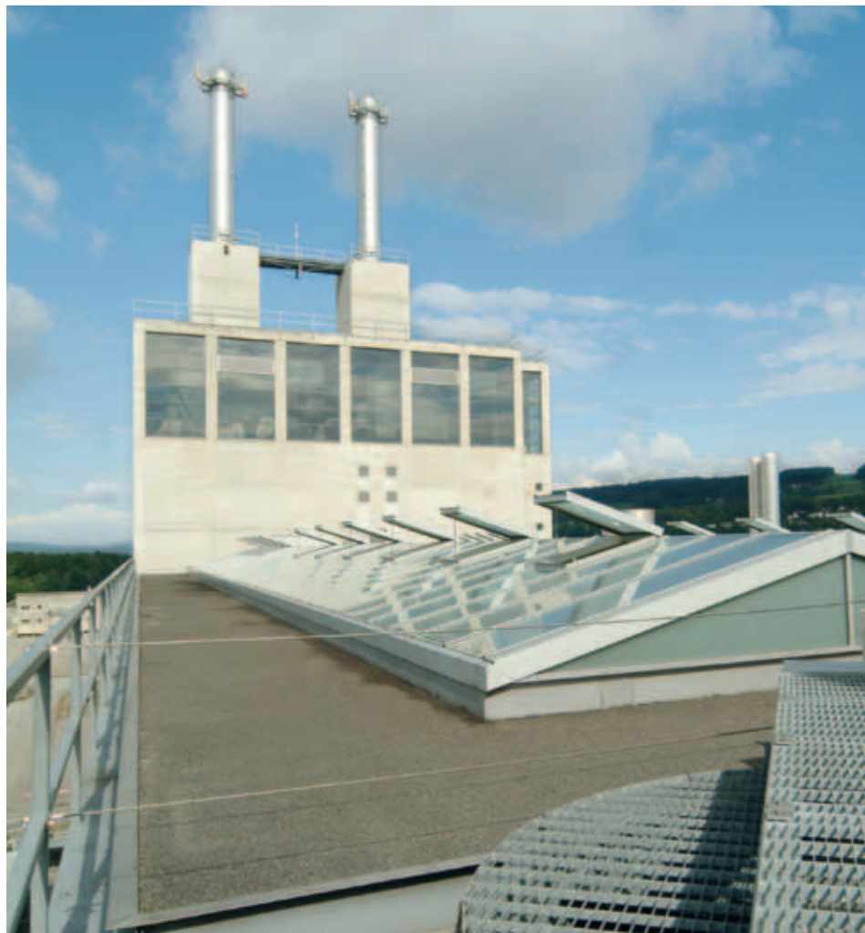
Saubere Energie aus thermisch verwerteten Abfällen: Die Kehrichtverbrennungsanlage des Verbands KVA Thurgau produziert als grösstes Kraftwerk im Kanton Thurgau wertvolle, einheimische Energie in Form von Dampf und Strom.
