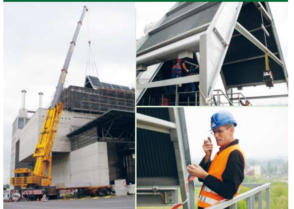
Das Reschka-Team bei der Erweiterung des Luftkondensators (LUKO): Mit dem 300-Tonnen-Kran wird ein Lukofeld auf das Dach gehievt und an den richtigen Platz gezogen und montiert. Nur mittels Funkanweisungen von SPX-Chef Walter schafft es der Kranführer mit viel Gefühl und Präzision, das Lukofeld auf wenige Zentimeter genau am richtigen Ort zu positionieren.
