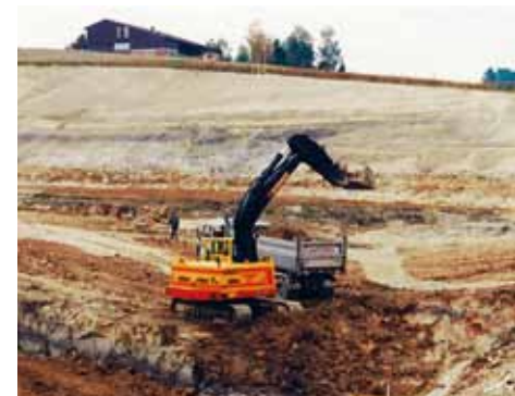
Baubeginn der Deponie Emmerig im Juni 1994.
