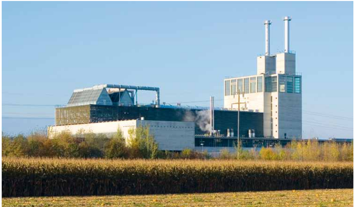
Das Kehrichtheizkraftwerk des Verbands KVA Thurgau weist eine hervorragende Ökobilanz aus und gehört somit zu den effizientesten Anlagen in der Schweiz.
