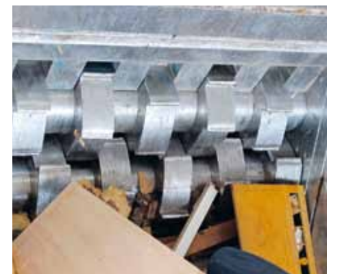
Im Schredder der KVA dürfen nur sperrige brennbare Abfälle zerkleinert werden.
