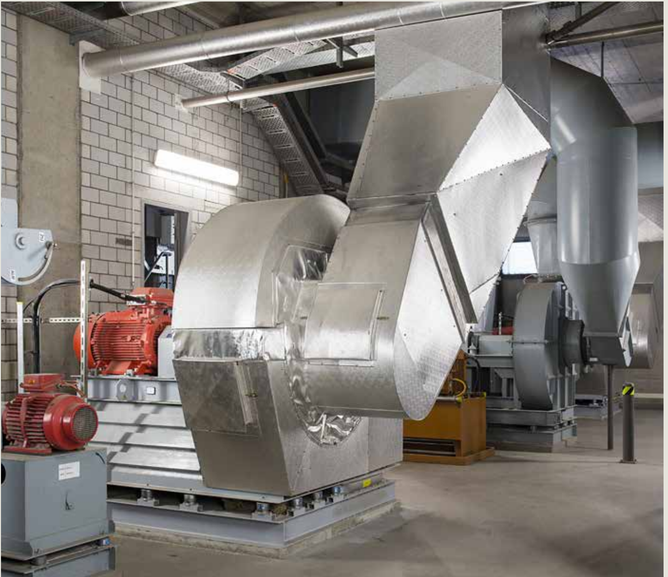
Gebläse für Verbrennungsluft
