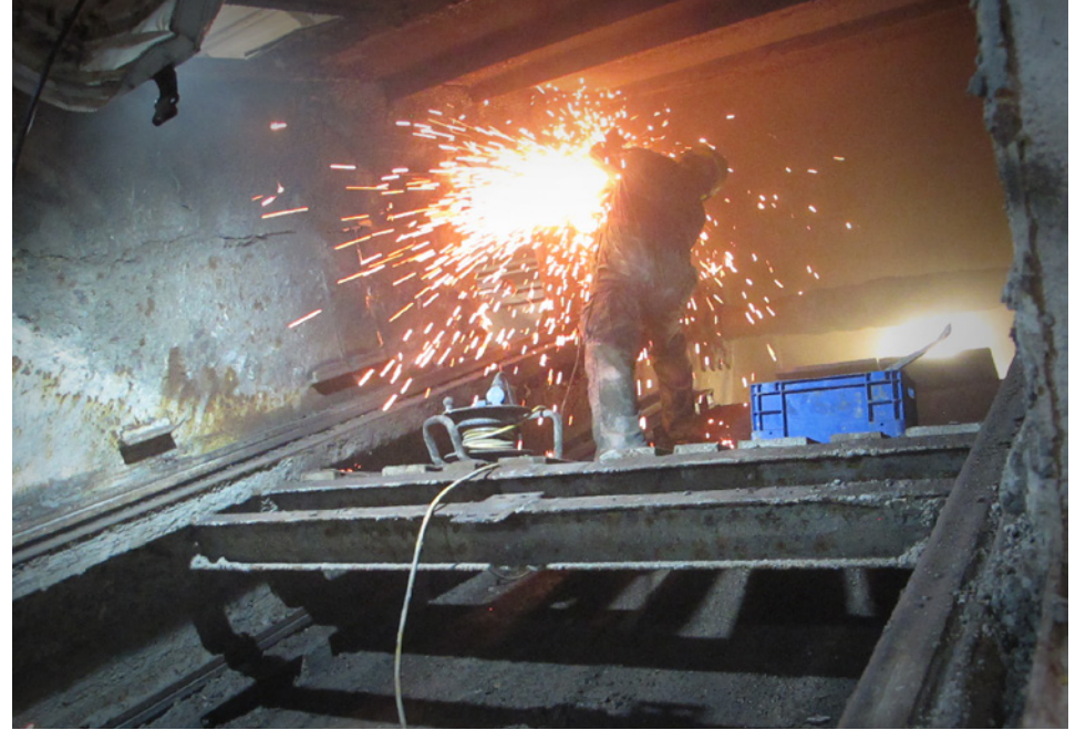
Revisionsarbeiten im Schlackenausstrag des Ofens
