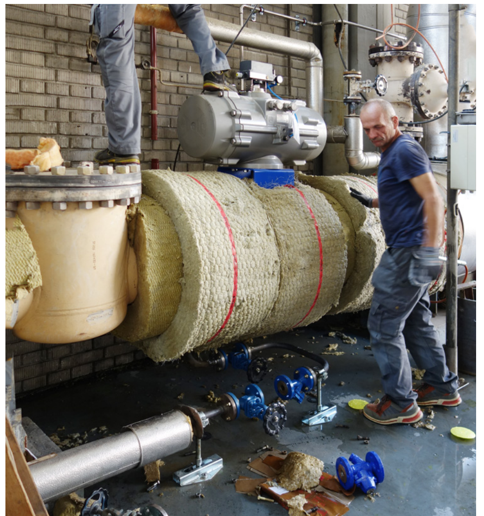
Einbau Dampfregelschieber beim Dampfabnehmer
