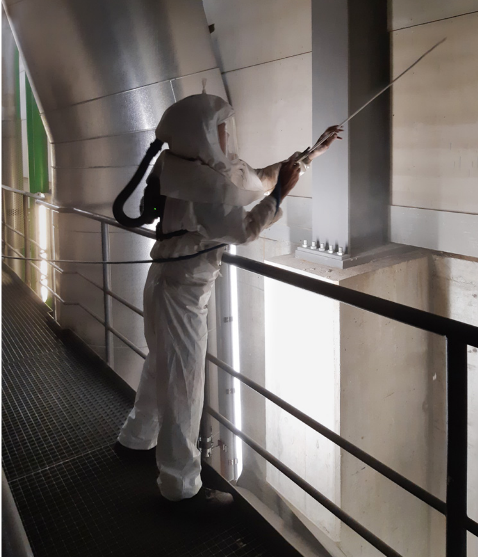
Reinigungsarbeiten Kesselhaus
