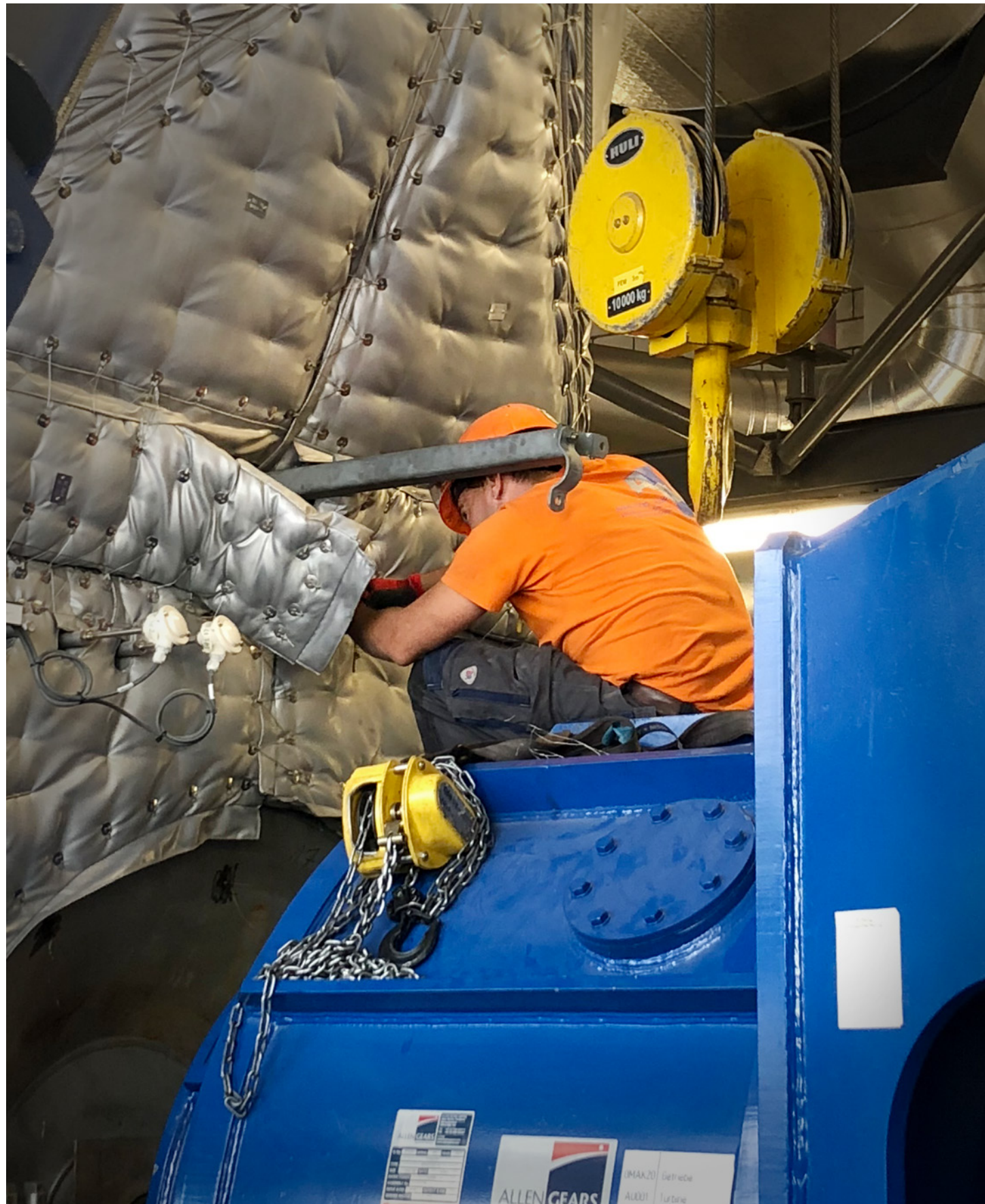
Revision Dampfturbine
