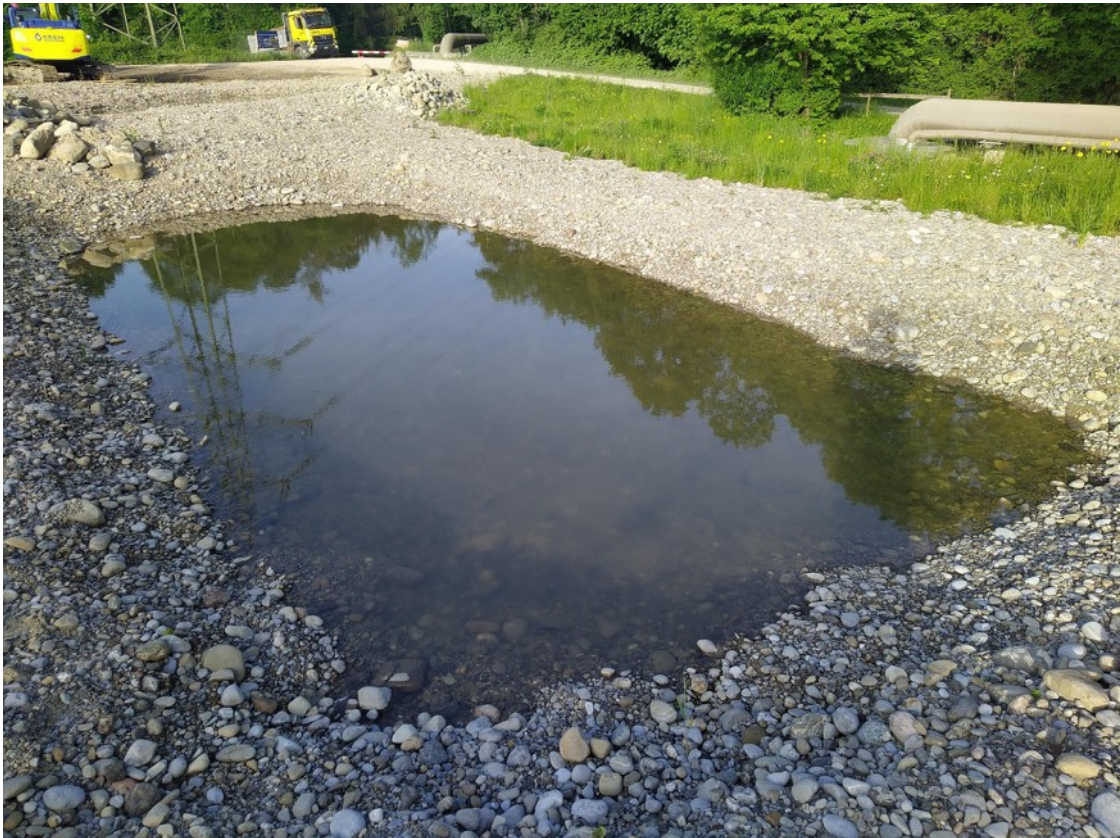
Ersatzfläche Nord: Beton-Ablasstümpel (17.05.2022)
